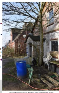
Die verfallenen Gebäude von Wohnhaus (links) und Kratzmühle (rechts).
